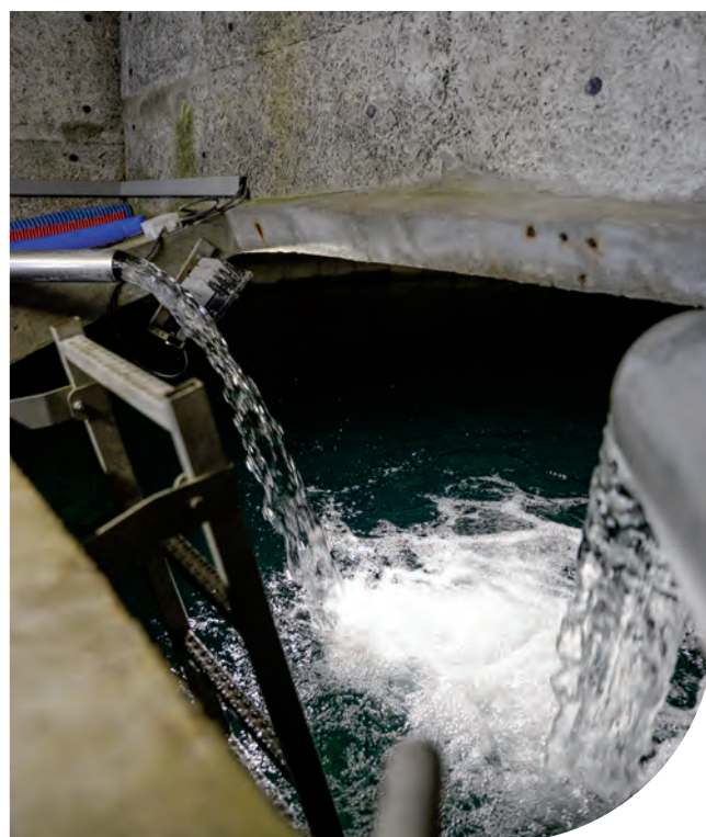
Réservoir intérieur, Fillings - La Mouille
