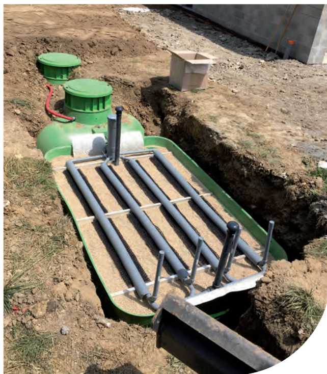
Chantier d'installation d'un assainissement non collectif
