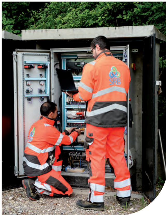
Intervention armoire électrique
