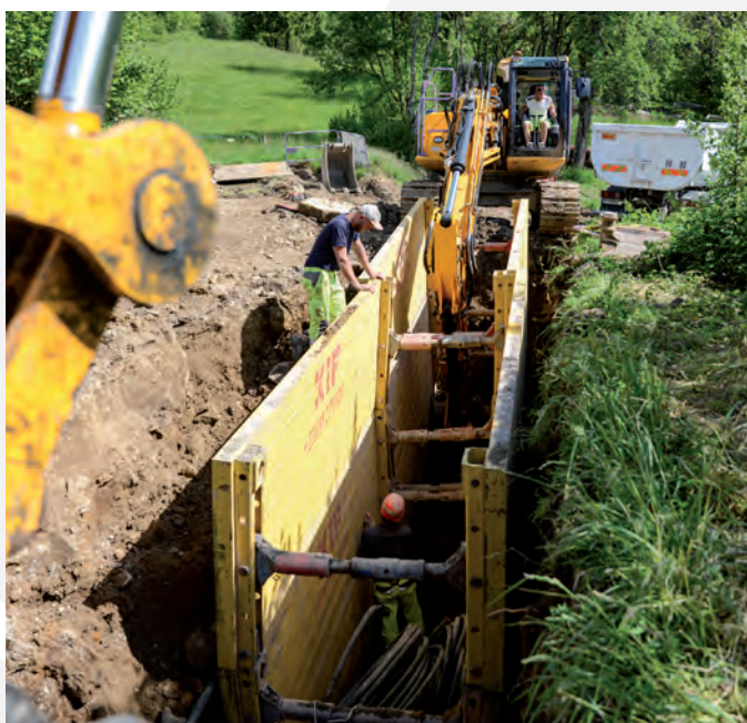
Chantier de réalisation du réseau structurant de la Vallée Verte
