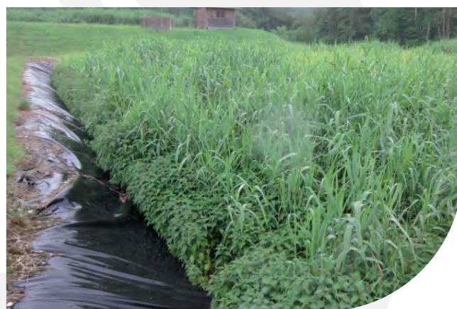
Station d'épuration de Burdignin Villard
