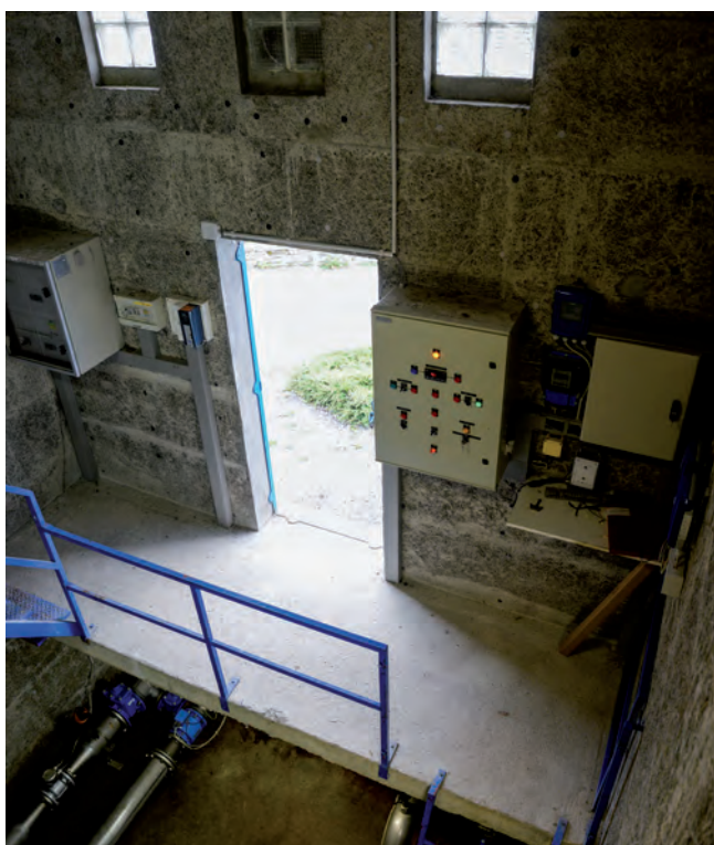
Réservoir intérieur, Fillings - La Mouille
