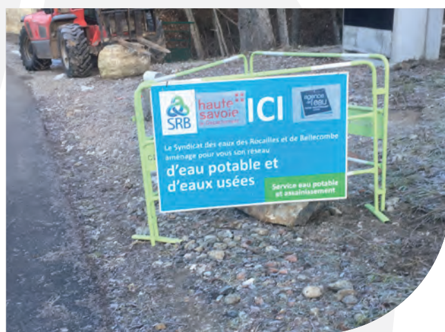
Panneau d'information sur un chantier du SRB
