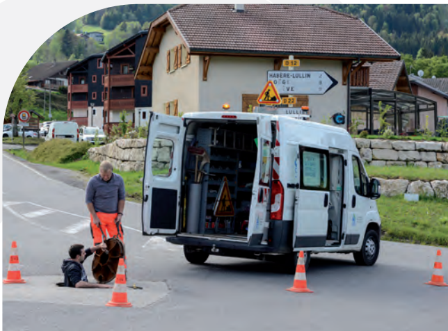
Intervention réseau à Habère-Poche
