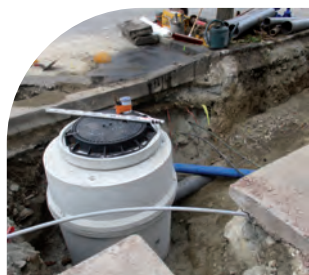
Travaux mise séparatif Reignier
