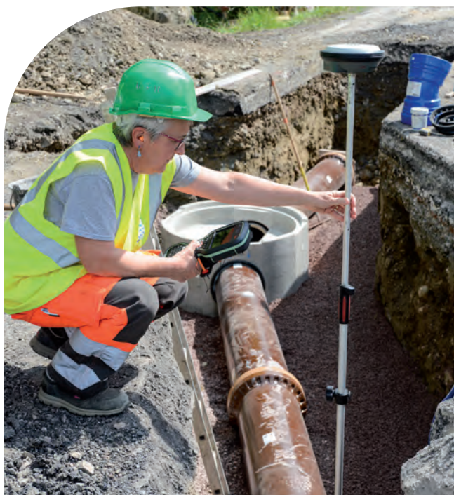
Intervention réseau GPS au Pont de Fillings
