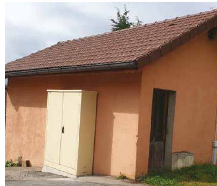
Armoire de connexion principale
