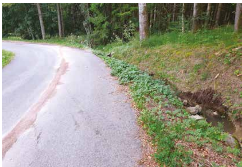
Liaison principale en souterrain
